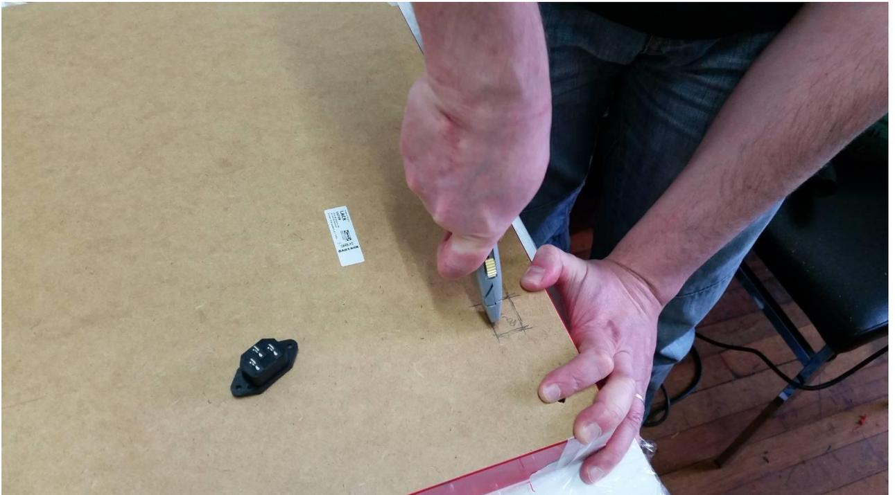
2. Remova o plugue da parte posterior das extensões de alimentação, alimente o cabo pelo interior da mesa e traga-o para fora do buraco para o conector IEC. Agora você pode soldar os fios ao contrário do conector IEC e encaixá-lo no lugar.
